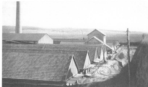
Trockenhütten des Ziegelwerkes Ernstbrunn 2
